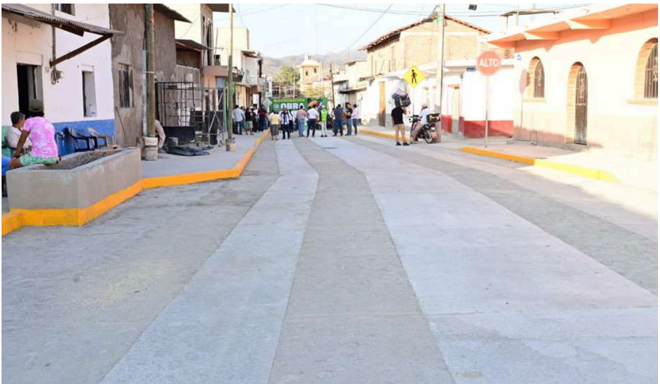
Pavimentación de calles
