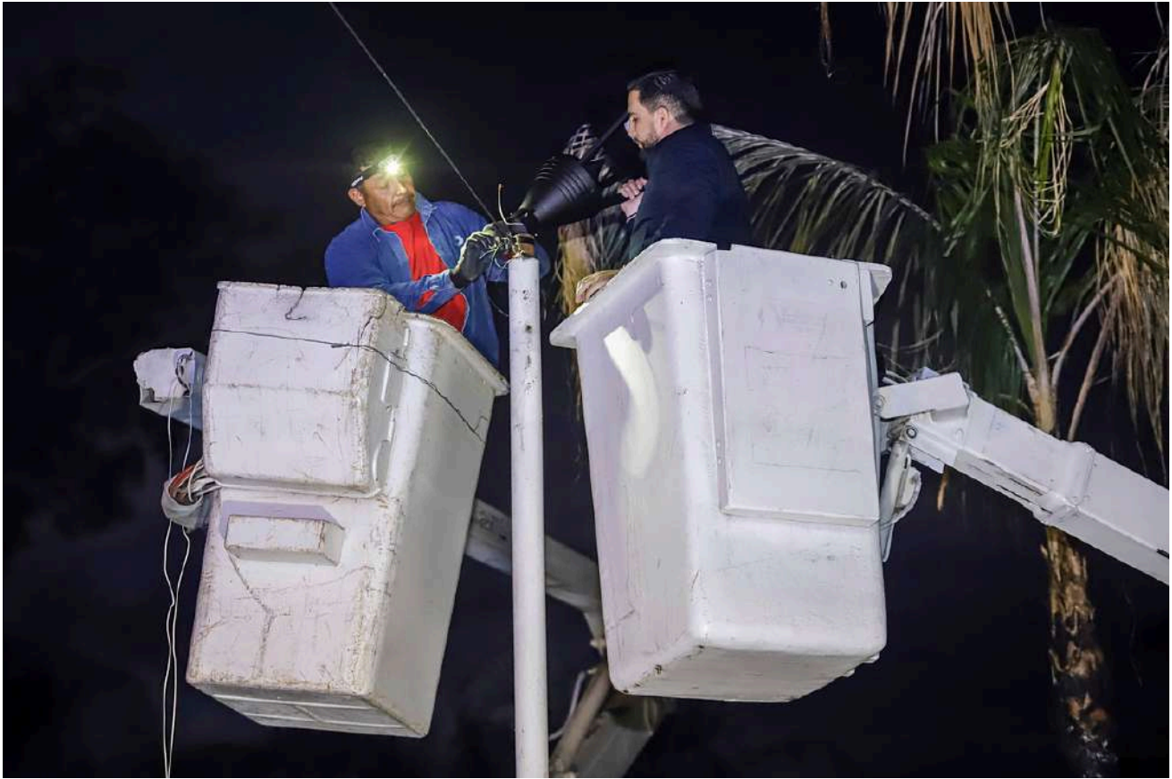
Instalación de luminarias nuevas
