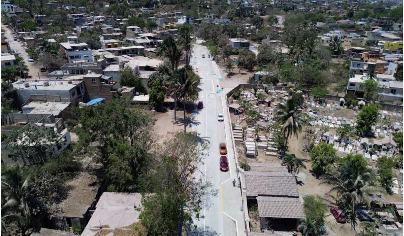
Pavimentación de calles
