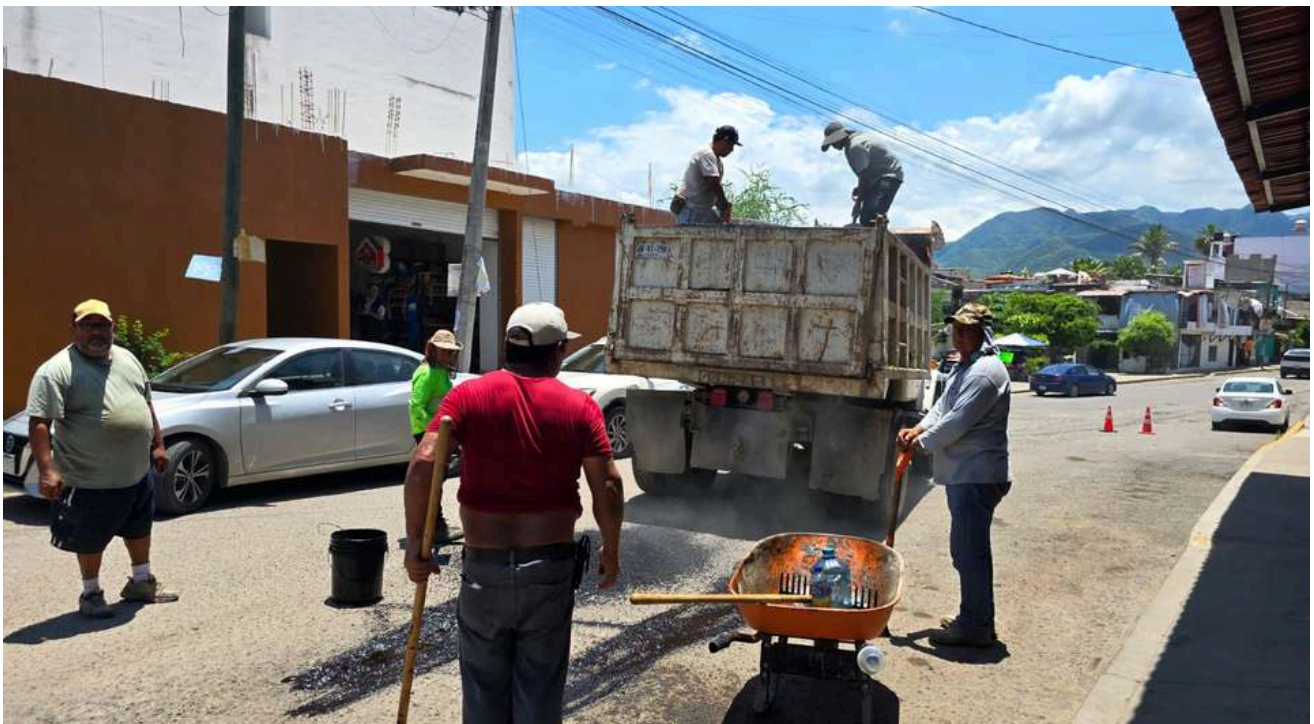
Pavimentación de calles
