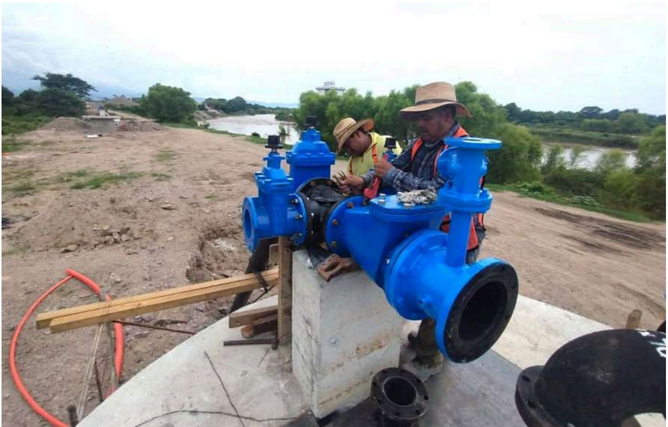
Mantenimiento del equipo de extracción de agua
