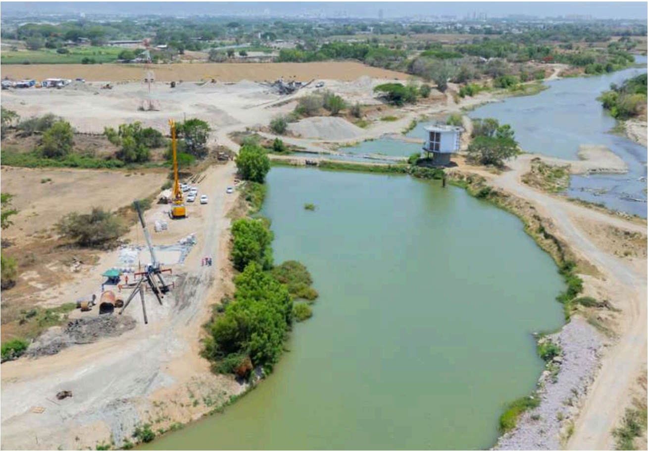
Mejoras en la extracción de agua del pozo radial
