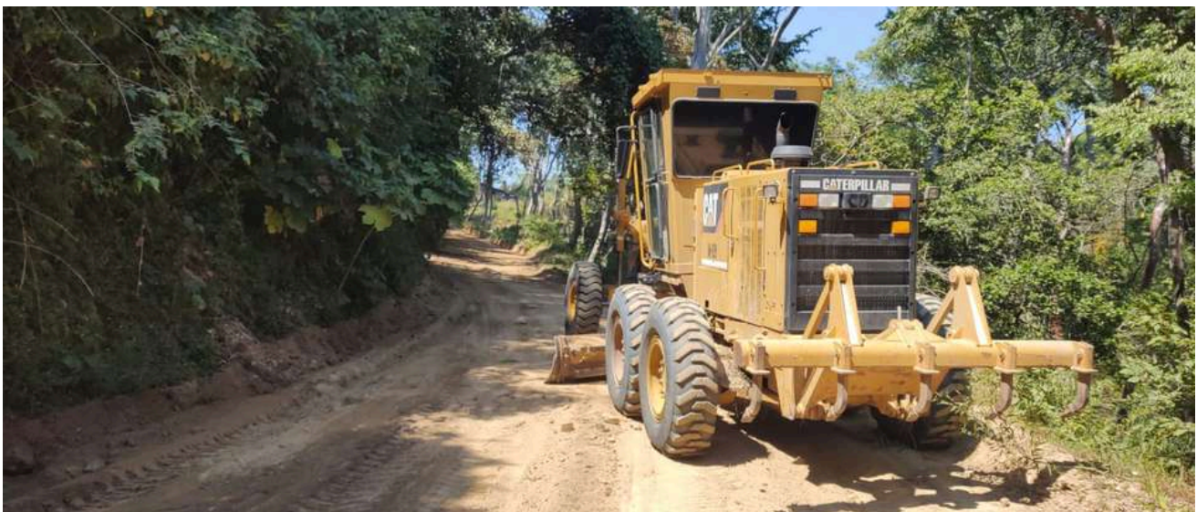
Limpieza de caminos en el campo.
